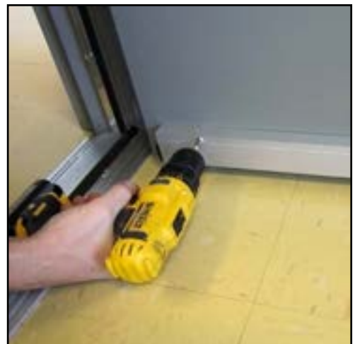
5. Install door bottom.
